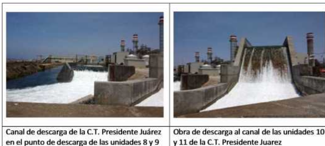
Figura 2.- Canal de descarga de la C.T. Presidente Juárez en el punto de descarga de las unidades 8 y 9. Obra de descarga al canal de las unidades 10 y 11 de la C.T. Presidente Juárez
